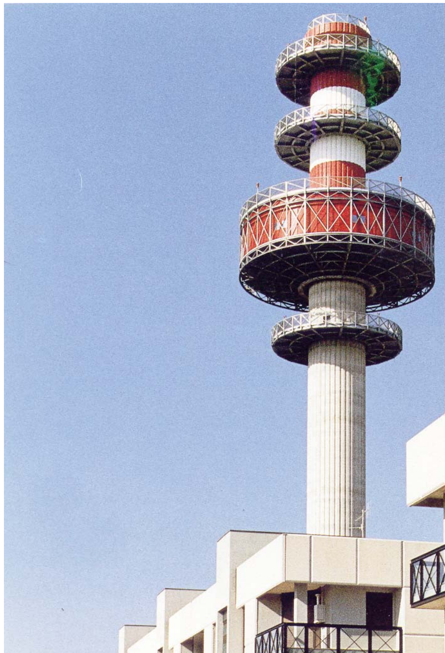
Catanzaro, Località San Cono Torre delle Telecomunicazioni
