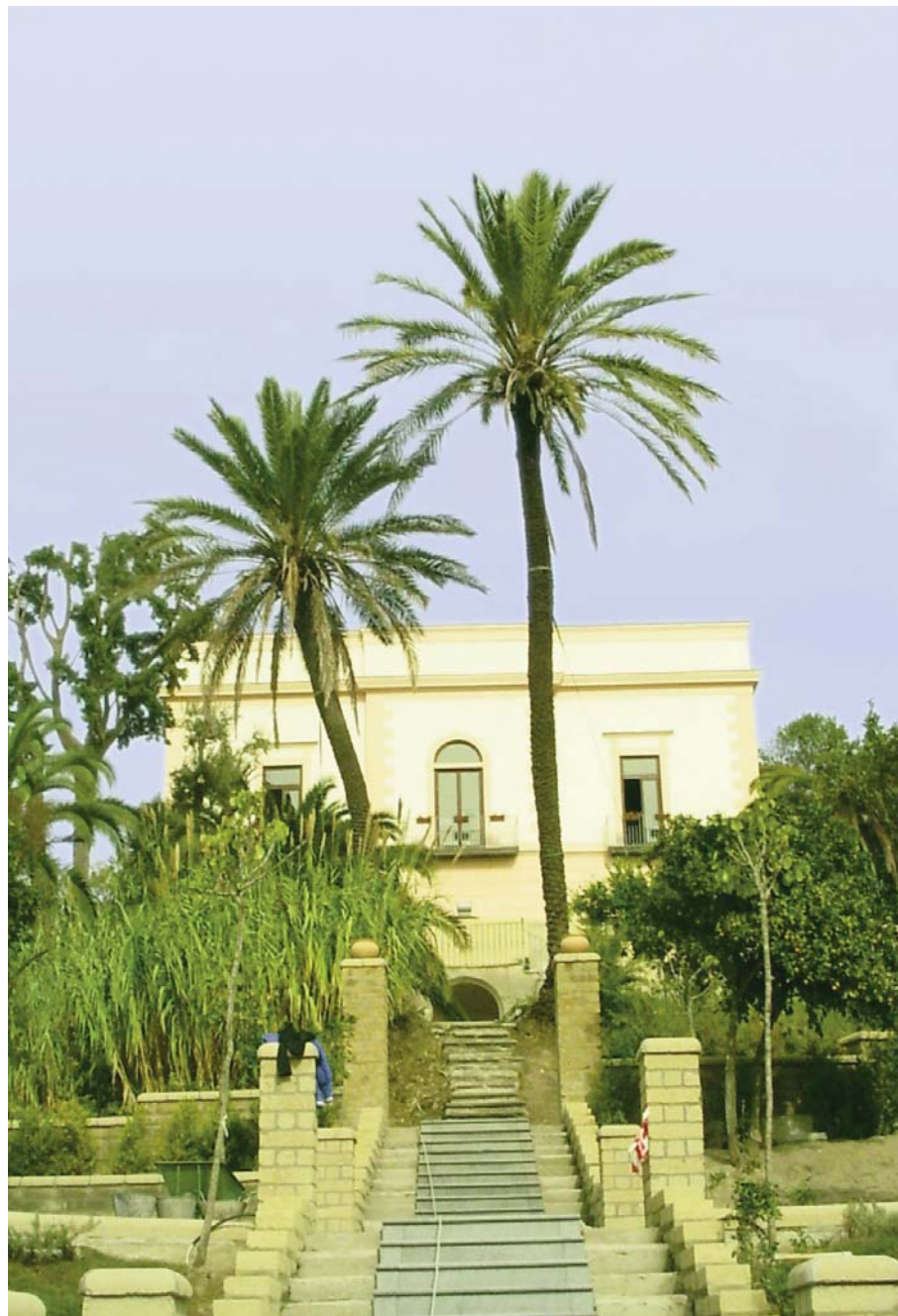
Bacoli, Villa Cerillo rampa di accesso al Parco, in corso di realizzazione
