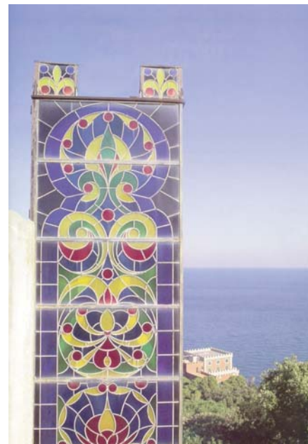
Isola d'Ischia, Comune di Forio Villa la Colombaia - Particolare vano ascensore
