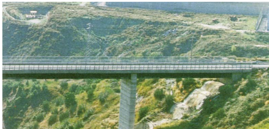
Catanzaro, Svincolo viadotto località San Cono
